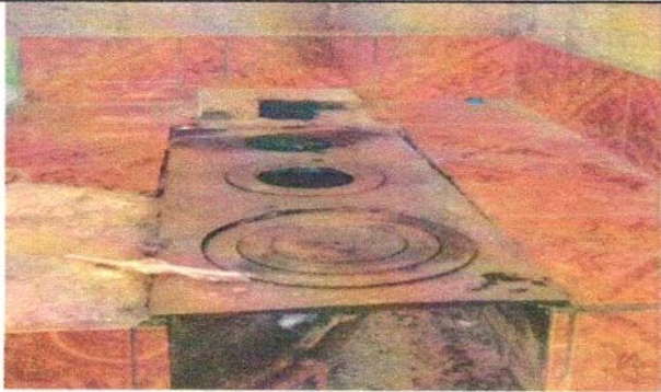
FOTO 9: Reparación o sustitución de área de cocina (Plancha)
