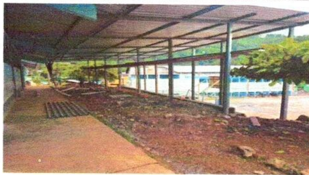
FOTO 6: Mejoramiento de losa de patio
