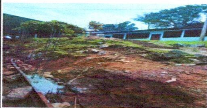
FOTO 5: Mejoramiento de muro perimetral con gradas
