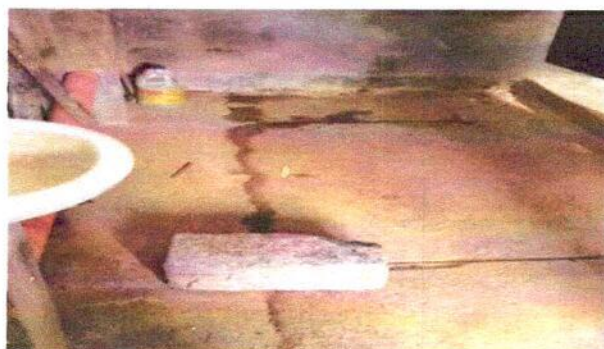
FOTO 3: Mejoramiento de piso de los sanitarios, instalando piso cerámico
